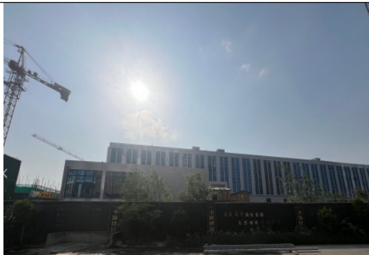
项目沿线现状图（一）
