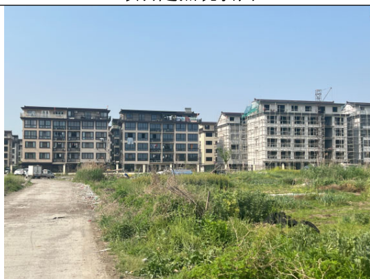
项目沿线现状图（一）
